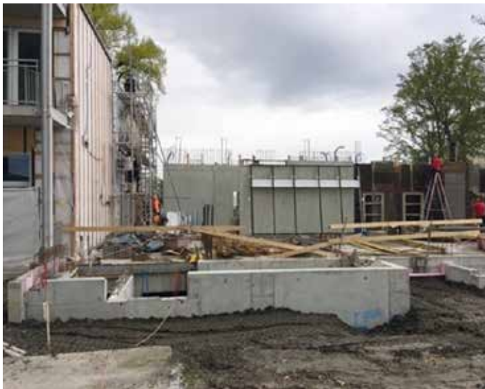
Stand der Arbeiten für das Erdgeschoss am 26.4.2022.
